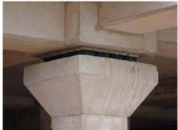
钢筋混凝土框架结构隔离支座，10Hz
